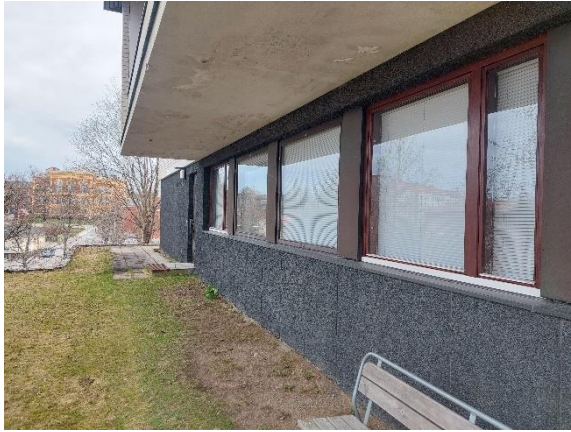
Parvekkeen alla olevat ikkunat paremmassa kunnossa
