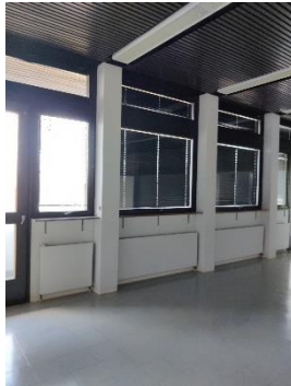
Yleiskuvia ovista ja ikkunoista. Metallirakenteiset ikkunat ja ovet ovat puurakenteisia ovia/ikkunoita paremmassa kunnossa.
