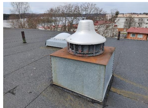
Poistoilman huippumuri vesikatolla.
