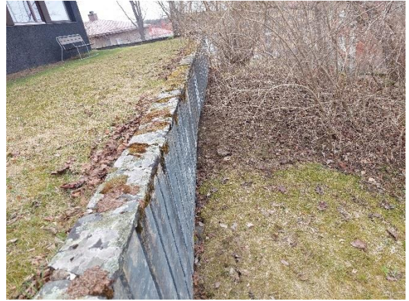
Betonirakenteinen tukimuuri
