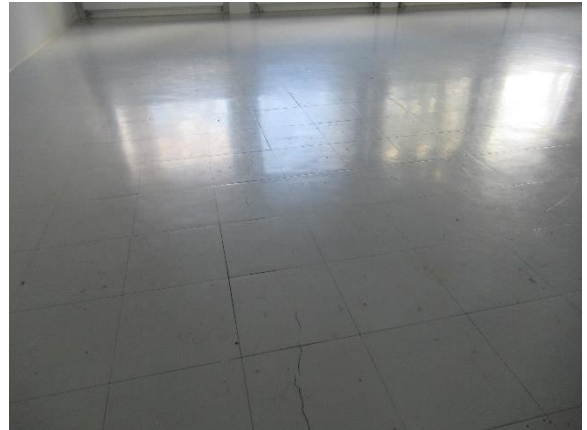
Halkeamia lattiapintamateriaaleissa
