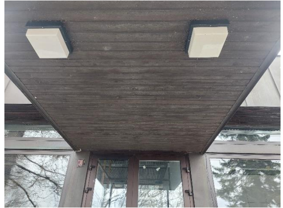
Pääsisäänkäynnin lippa, ei merkittäviä vaurioita
