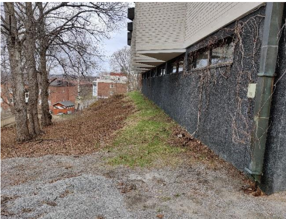
Yleiskuva rakennuksen vierustalta. Syöksytorvi johtaa sadevedet rakennuksen vierustalle.
