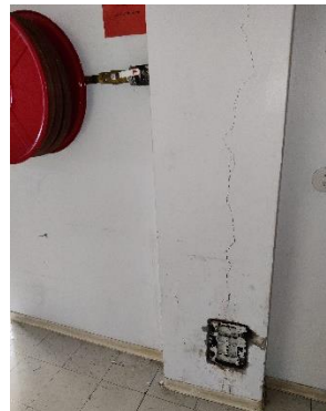
Vesi- ja viemärijohdot koteloinnin sisällä.
