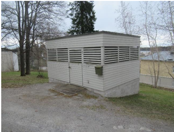
Harkkoperusteinen ja puurakenteinen jätekatos
