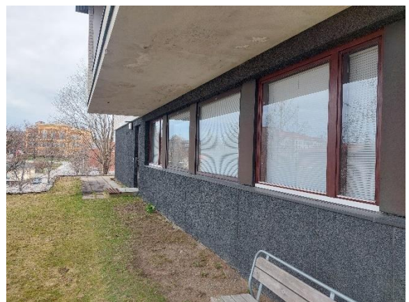
Vierustalla hiekkaa/multaa, paikoittain istutuksia
