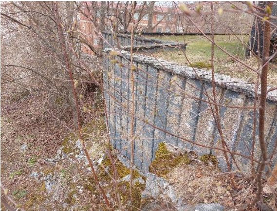
Betonirakenteinen tukimuuri
