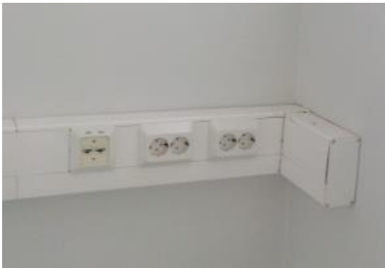
Rasiointeja johtokanavassa
