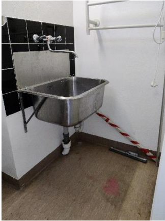
Alkuperäinen vesihana, uusittu allas.
