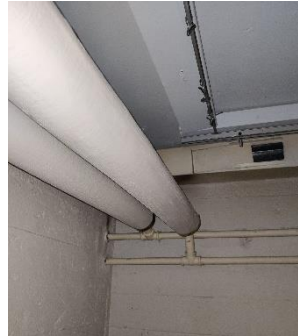
Alkuperäisiä lämpöjohtoja
