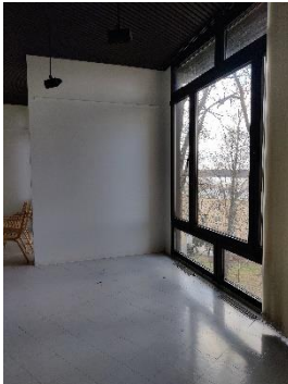
Yleiskuvia ovista ja ikkunoista. Metallirakenteiset ikkunat ja ovet ovat puurakenteisia ovia/ikkunoita paremmassa kunnossa.
