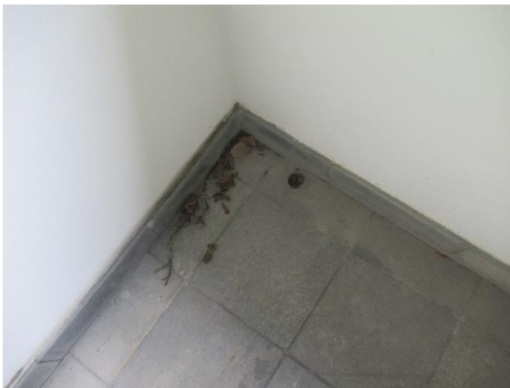
Parvekkeen lattia laatoitettu, vedenpoistoreikä lattiasa
