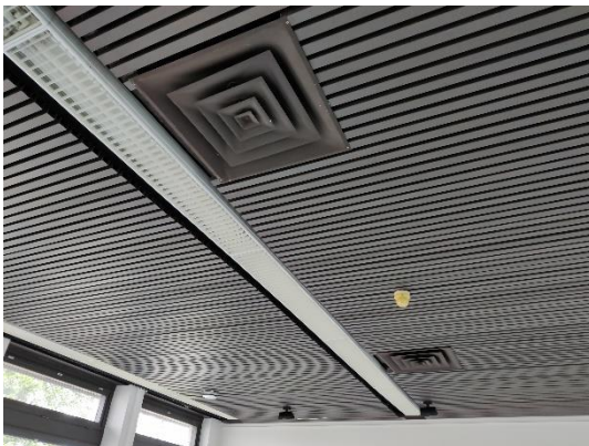
Keittiön poistoilmaventtiilit.
