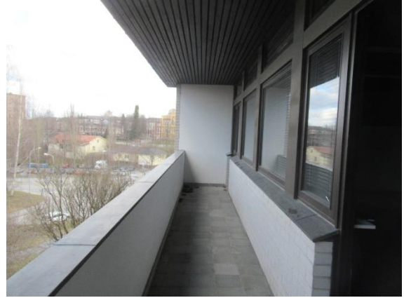
Yleiskuva parvekkeen sisäpuolelta
