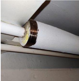
Alkuperäinen eristetty lämpöjohto
