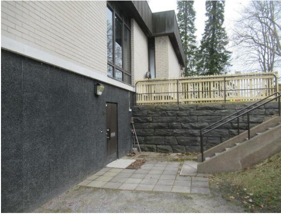
Betonirakenteiset portaat ja kivirakenteinen tukimuuri, joiden päällä teräskaitteet
