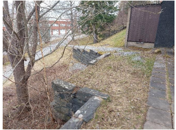
Kivirakenteinen tukimuuri ja varastorakennus
