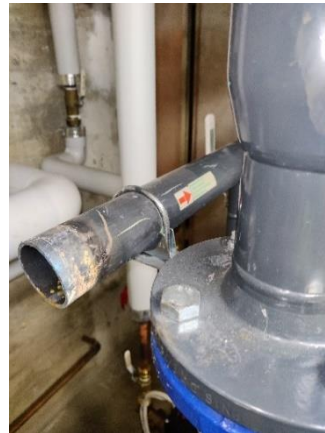
Rakennus kytketty irti kaukolämmöstä.
