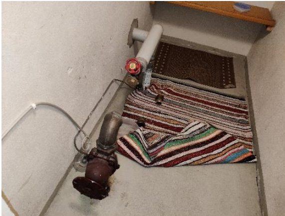
Kiinteistön päävesimittari poistettu.
